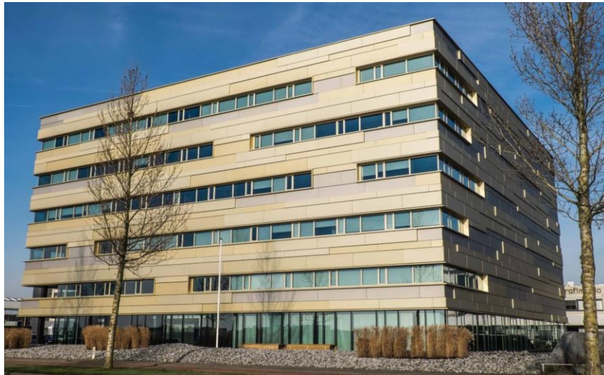
Nieuwbouw Gelders Archief (afbeelding: Gelders Archief).
