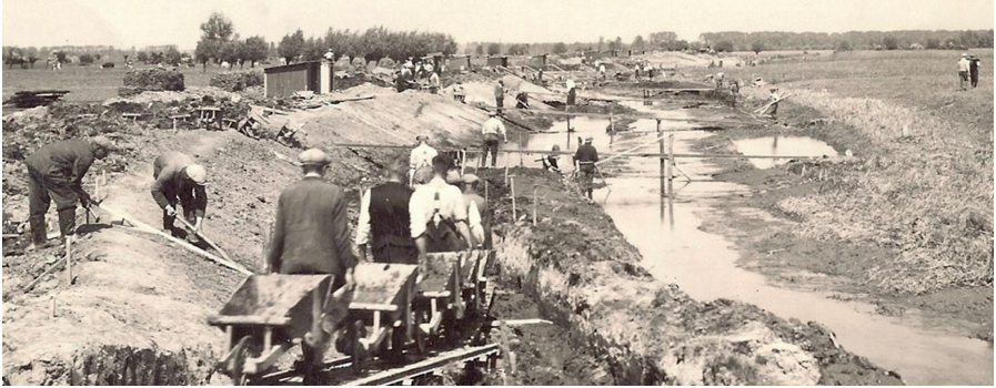
FIGUUR 4. AANLEG VAN HET VALLEIKANAAAL DOOR DE HEIDEMIJ IN HET KADER VAN BETERE ONTWATERING (KNHM FOUNDATION, 2023)
