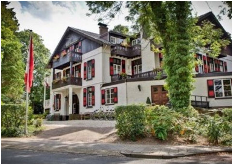
HOTEL DREYEROORD VOOR DE SLOOP EN VERBOUWING IN 2016
